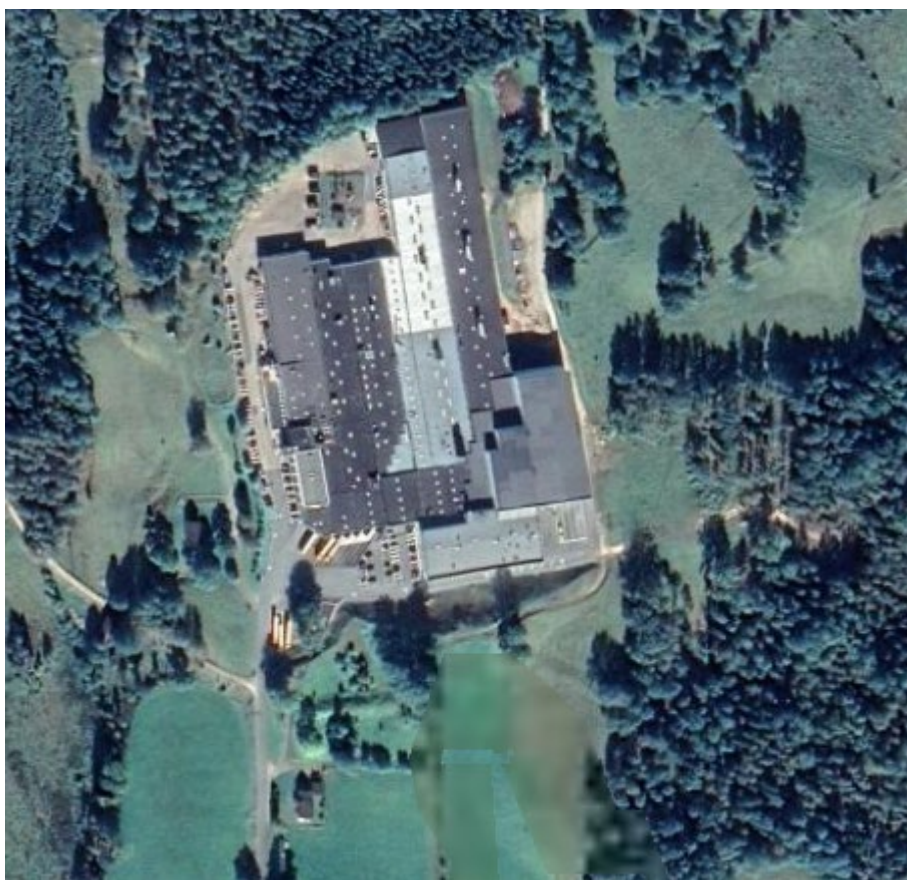
Flygbild över Troax industrianläggning
