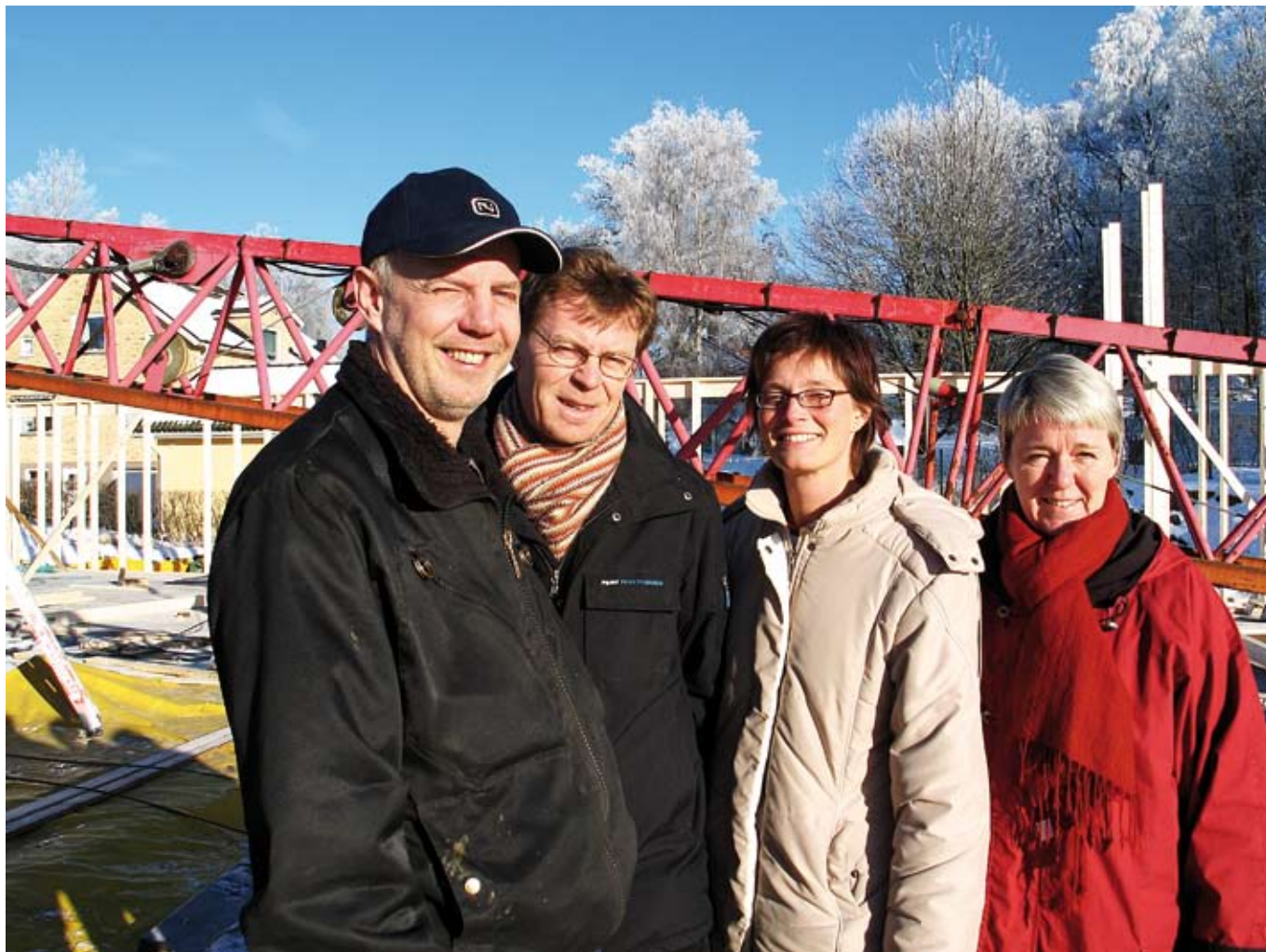
Göran Andersson, arbetsledare Almkvists bygg, Gunnar Lindow, fastighetsingenjör Gnosjö kommun till vänster. Till höger Ann-Christin Bucht och Ann-Marie Turesson, förskollärare på Regnbågens förskola som ser fram emot att från och med i höst få börja jobba i nya fina lokaler.
